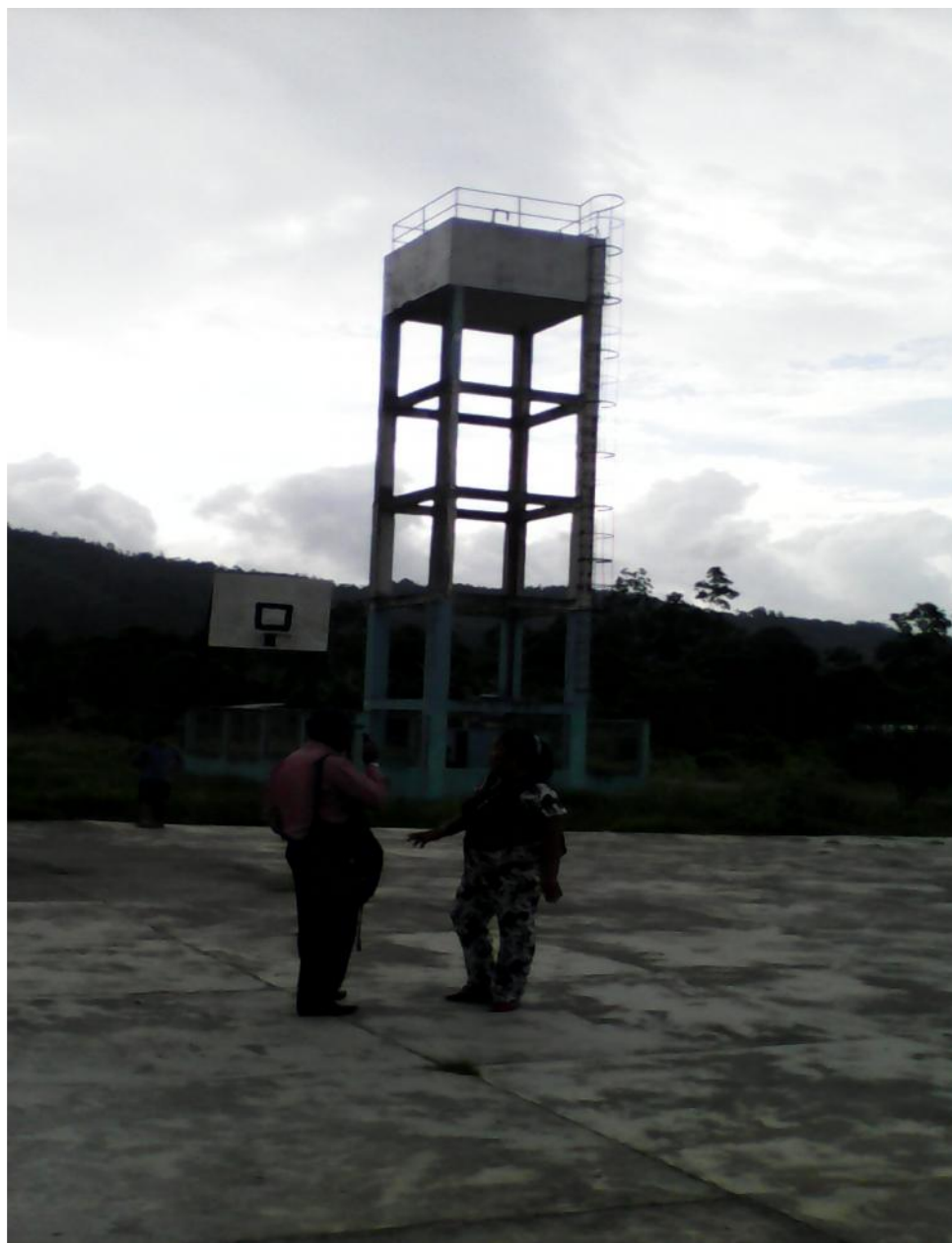
istema de Agua Potable; implementado por el SYMAE – GADMCE. Recinto Comuna “Li
