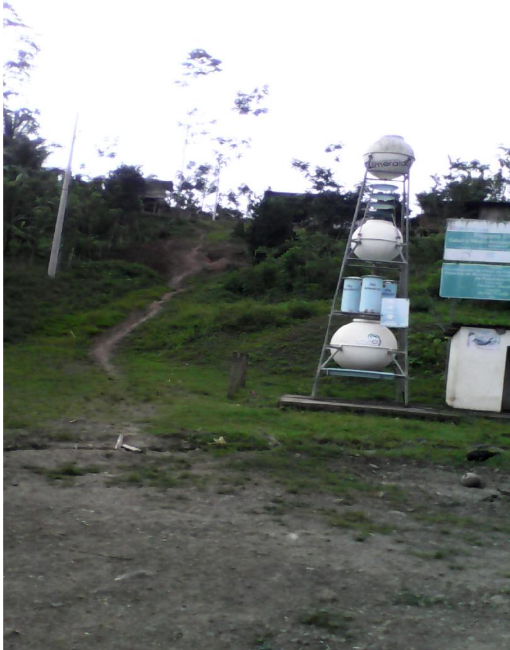
Sistema de Agua Potable; implementado por el SYMAE – GADMCE. Recinto:
