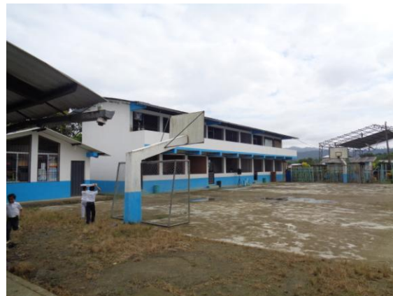
Foto 4. Escuela y colegio de la Parroquia de Chumundé.
