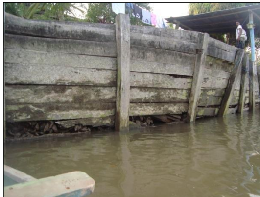
Fotos. 26 - 27 Recinto El Capricho recubren el suelo y construyen muro de contención con estopa
