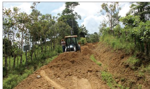
Maquinaria pesada realiza el acarreo de material sub base y base mejorado, a lo largo de 4 kilómetros; el trabajo es arduo pero tiene el propósito de optimizar la condición vial..
