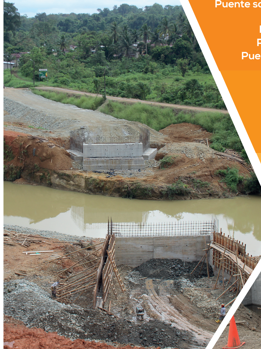
Puente sobre río Cachaví
