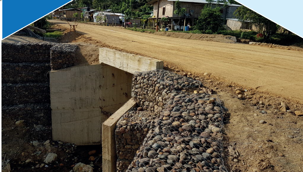
Vía y alcantarillas en Bilsa
